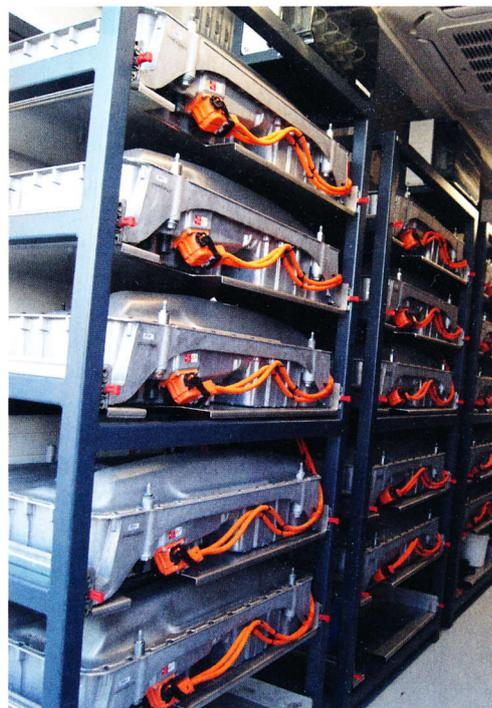
50 gebrauchte Fahrzeugbatterien wurden zu einem Speicher zusammengeschlossen, der auch den Ladestrom für die Busse mitliefert.
